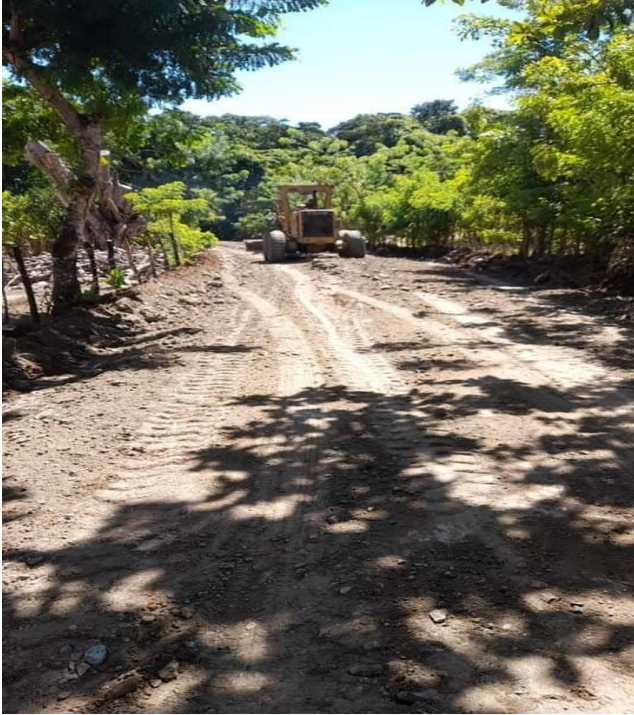
Acondicionamiento de la calle en la comunidad de El Carril.
