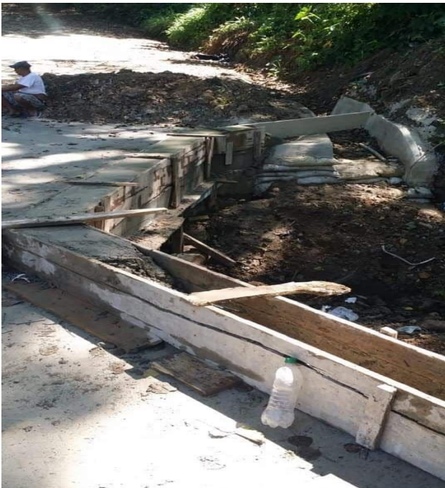
Alcaldía Municipal continúa con la reconstrucción del puente del Toronjo. Por la entrada de la iglesia, en la Guama.
