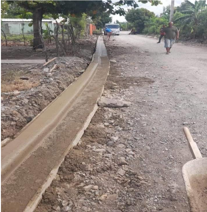
Construcción de contenes en la comunidad del Carril por Autoridades de la Alcaldía.
