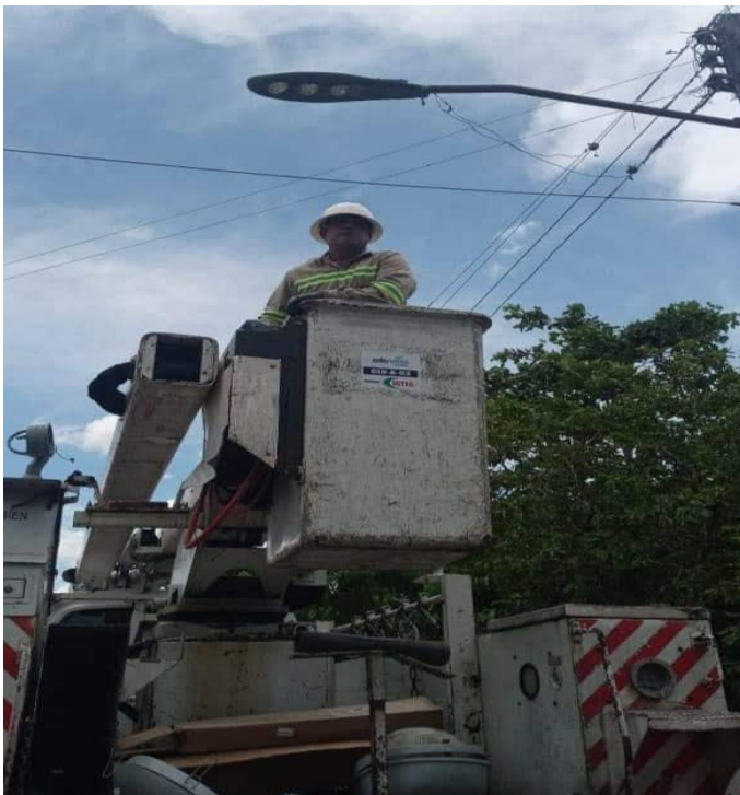
Cambio de luces en la comunidad de la Penda, en Calle Del Río y la Urbanización Sánchez por Autoridades de la Alcaldía.
