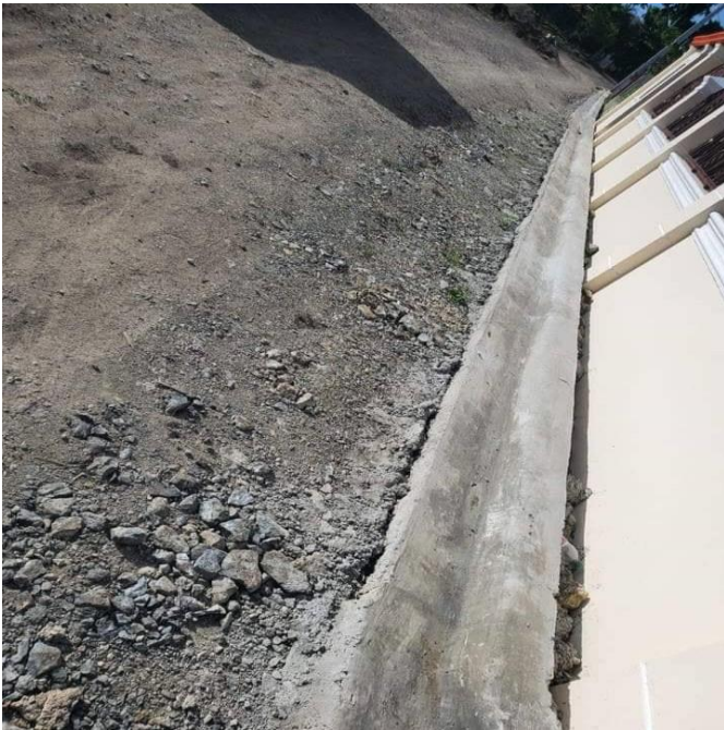
Construcción de contenes en la comunidad de la Guama por parte de las autoridades de la Alcaldía de Cayetano Germosén.
