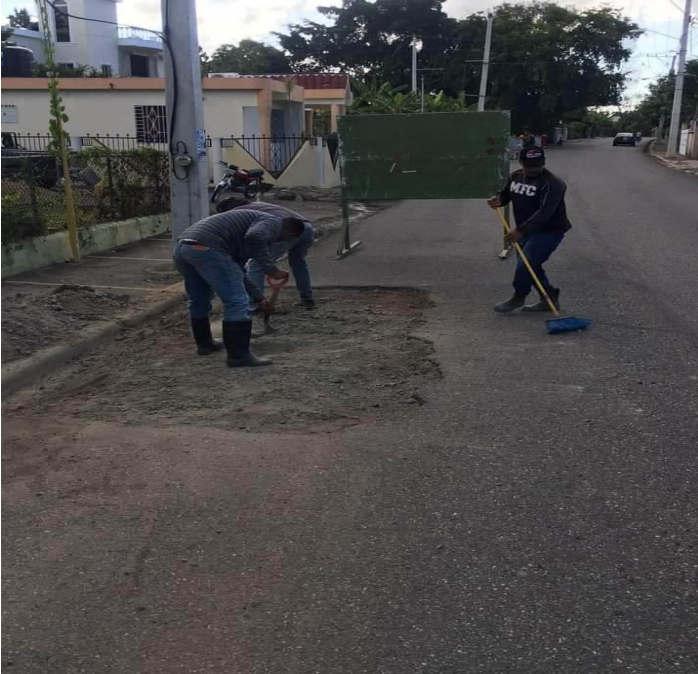
Acondicionamiento de baches en el Municipio de Cayetano Germosén.
